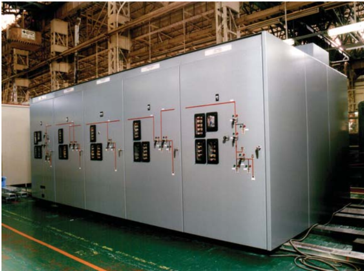
台灣鐵路局後龍變電所 69KV C-GIS Taiwan Railway Ho Long Substation 69KV C-GIS
