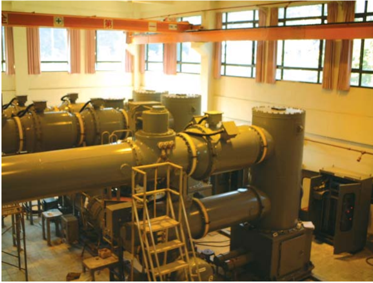
北宜高速公路 161KV GIS 安裝 Pei-Yi Free way
