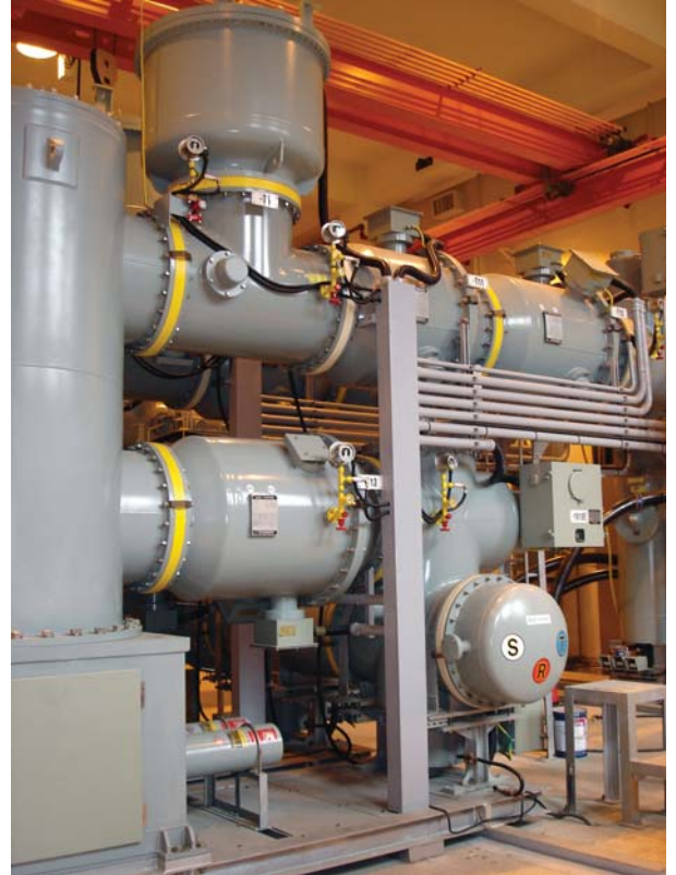
北宜高速公路 69KV GIS 安裝 Pei-Yi Free way
