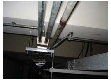
通信電纜配管工程 RSG PIPE installation
