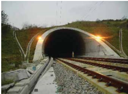
R2 工區30條隧道臨時電源架設及2年維修保養 R2 30 Tunnels Temporary Power Line Installation & 2 Years Maintenans (2004~2005)
