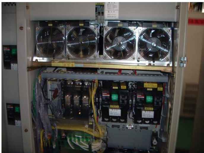
不斷電裝置定期保養 UPS Routine Maintenance
