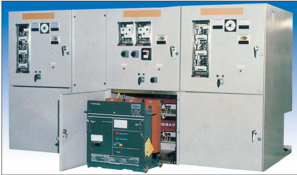
閉鎖型高壓配電盤 3.6/10KV Metal Clad Switchgears
