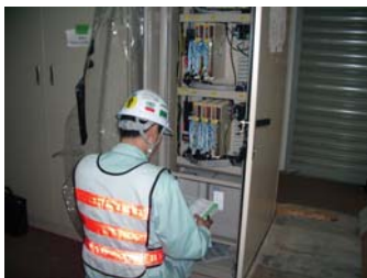
BS-RTU 組立,安裝 35 套 BS-RTU unit 35 Sets
